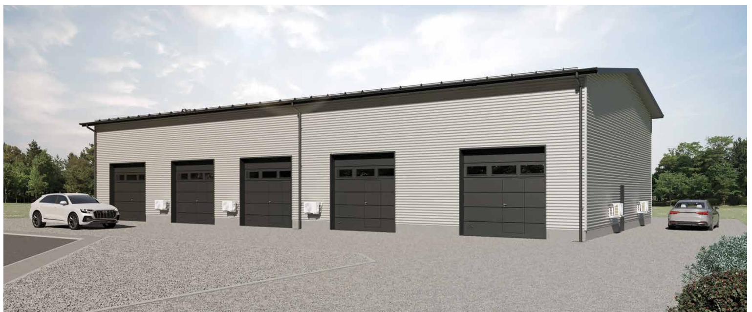
Business Park Tyrnävän ensimmäinen vaihe valmistuu syksyllä 2024. Kuva: Desto Oy.
