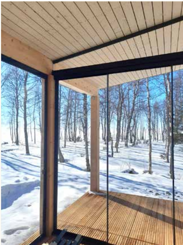
Lasitettu terassi tuo lisäneliöitä päärakennukseen sekä Usva-rakennukseen. Se mahdollistaa merenrannan luonnon tarkkailun lämpimästä tuulensuojasta käsin.
