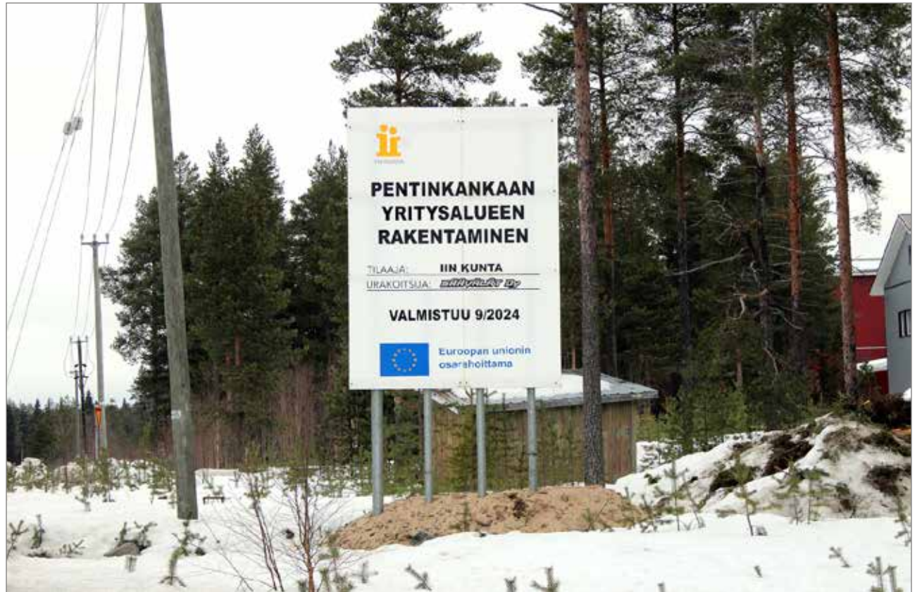
Pentinkankaan yritysalueen rakentaminen on käynnistynyt.
