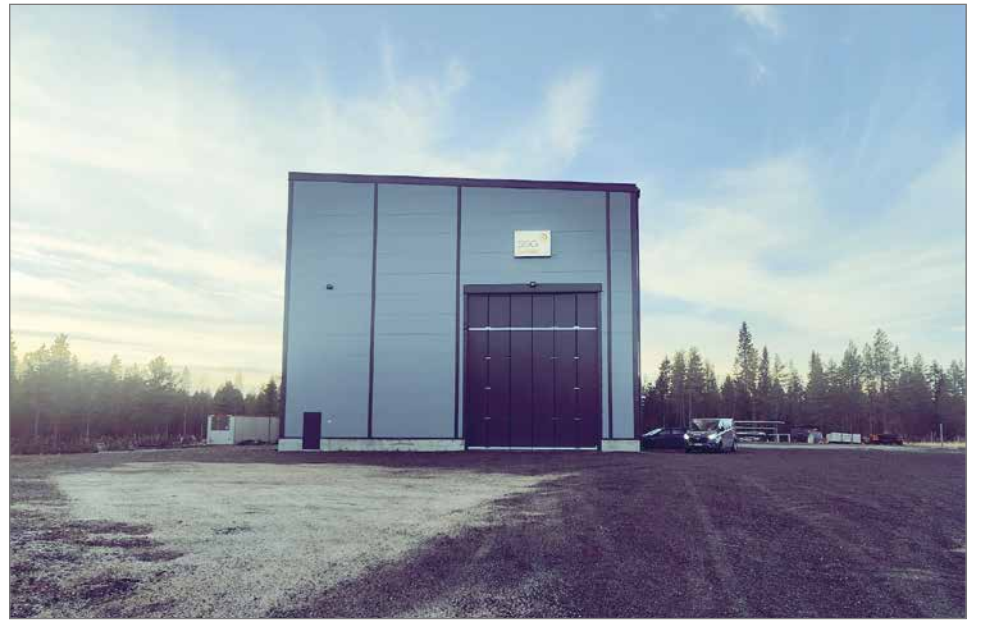
Tyrvävän Murrossa sijaitseva halli on osoittautunut SSG Sahalan toimipisteelle täydelliseksi. Kuva: Ville Saarela
