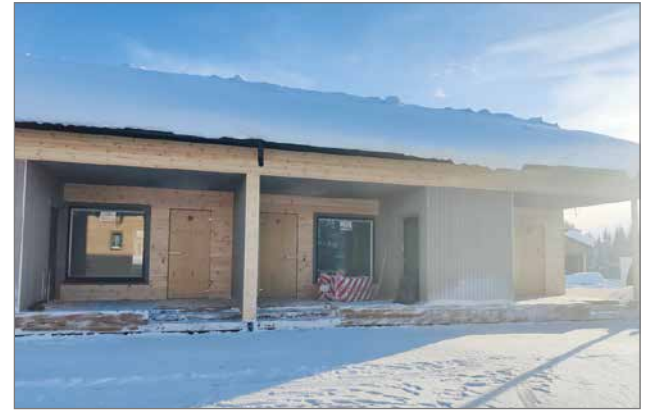
Syötteen Kärrikujalle on rakentumassa neljä uutta hirsistä rivitaloa, joihin asukkaat pääsevät muuttamaan jo elokuussa.
