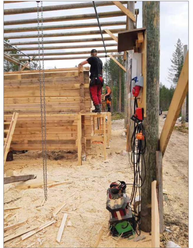
VK Hirsi Oy tekee uudiskohteiden hirsiveistotyöt käsin perinteisillä menetelmillä.
