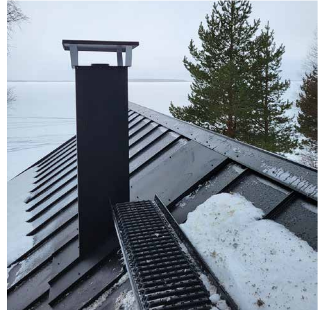
Watti-Jouko piipunpellityssarja asennettuna. Kuva: Suomen Savupiipputeollisuus.
