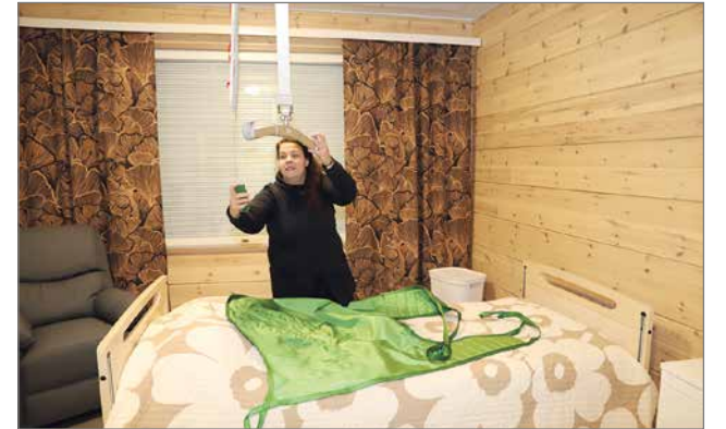
Ryhmäkodin Vastuuyksiköpäällikkö Marja Lohvansuu esittelee B-puolen huoneiden nykyaikaisia apuvälineitä. Kuvassa näkyvällä liinalla ja kattokiskosta olevalla henkilönostimella onnistuu asukkaan avustaminen ergonomisesti pyörätuoliin, viereiseen tilaan wc-istuimelle tai pesulaverille.
