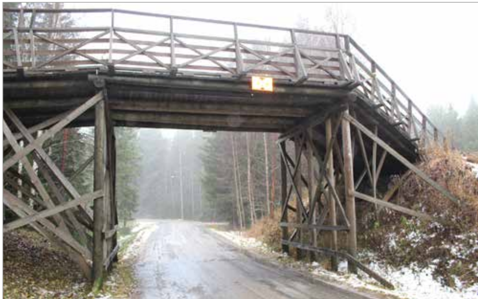
Iin kunnan talousarvio vuodelle 2024 sisältää määrärahan Illinsaaren hiihtosiltojen uusimiseen.
