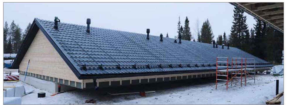
Kahdessa rivitalossa oli valmis katto valmiina nosturilla nostettavaksi, jolloin yhden päivän aikana tehdään hirsiasennukset ja katto lasketaan sitten paikoilleen.
