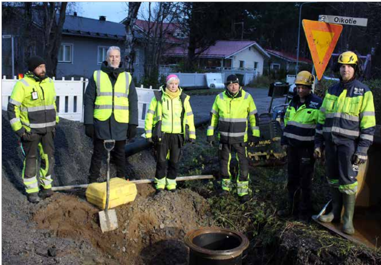
Iin kunnan kunnallistekniikan työntekijä Mikko Tammi, kunnallistekniikkapäällikkö Reto Vartiainen-Bürki, ympäristöasiantuntija Taija Savilaakso ja kunnallistekniikan työntekijä Ilpo Tumelius tarkastamassa hulevesikaivon asentamista yhdessä Maanrakennus J Päckilä Oy:n Tapio Päckilän ja Eemil Jokelan kanssa.
