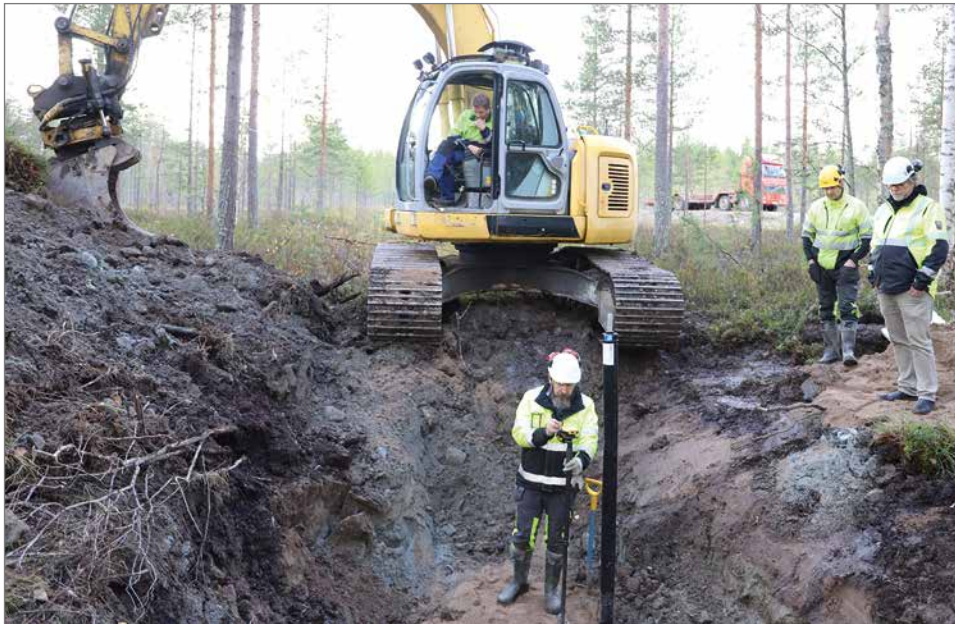
Tuotantotien varressa vaarinkujan lähellä runkovesijohdon vuotokohdan korjaustyössä verkostoinisööri Timo Turja. Työtä seuraamassa laitosmies Mika Hemmilä ja toimitusjohtaja Pertti Sipola. Juha ja Kari Vikströmin kaivinkoneen ohjaimissa Pekka Kempainen.
