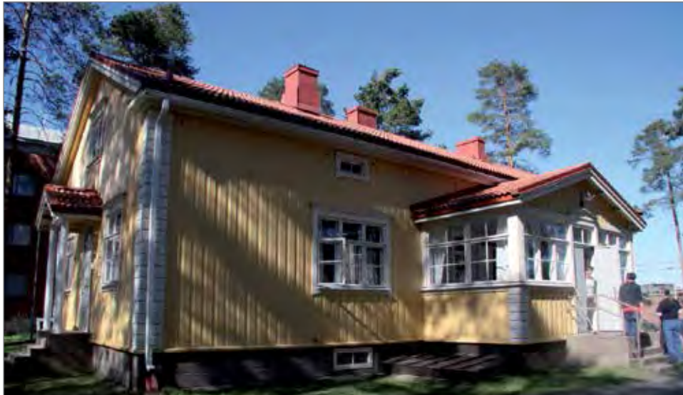
Kumpulan- kiinteistö sijaitsee Jukolantien varressa lähellä valtion virastotaloa. Kiinteistössä on tilat neljälle asukkaalle.
