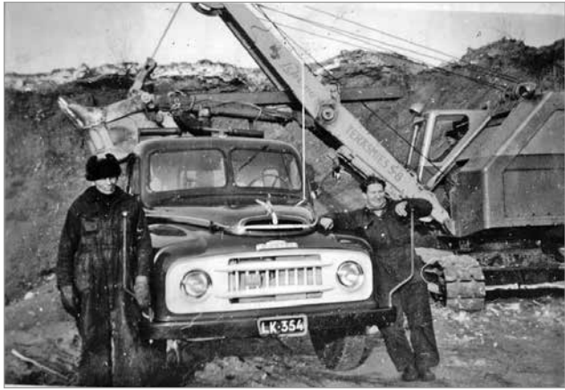
Erkki Kyröläinen lastaa Eero Laurilan Teräsmies-kaivinkoneella sora Simppalassa. Kuva: Juhani Tolonen
