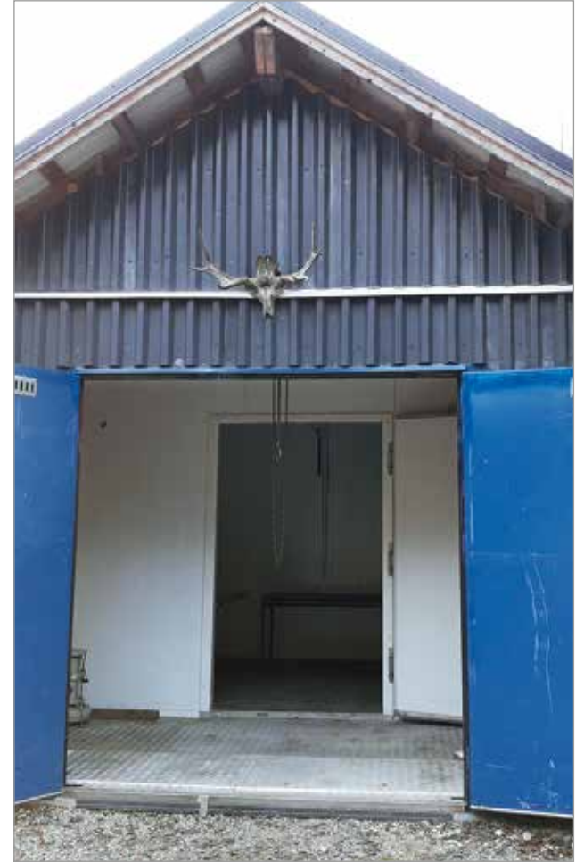
Talkoilla rakennetussa lahtivajassa on erillinen nylkytila ja lämpöeristetty sisätila.
