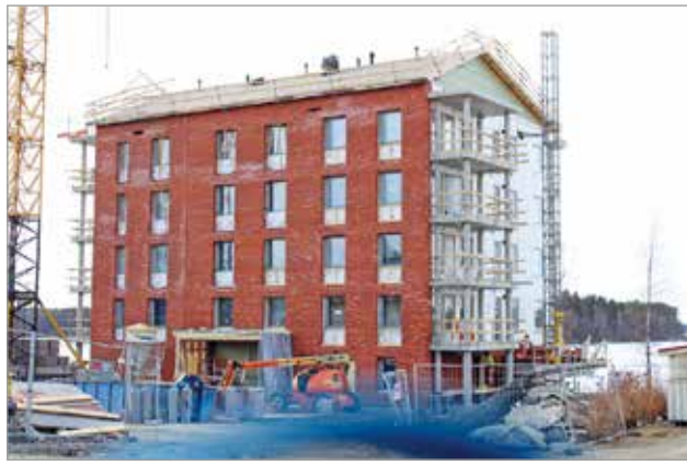
Temotek rakentaa kerrostaloa lijoen rantaan. Talo valmistuu syksyllä 2020.
