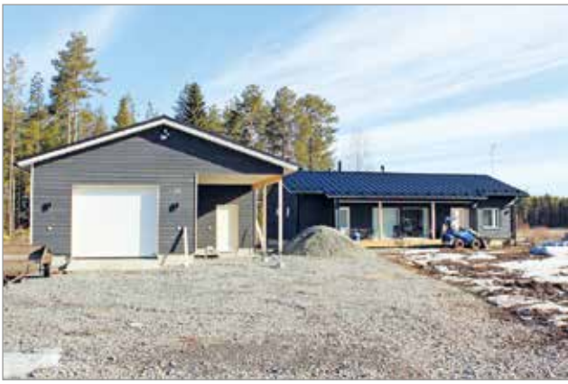
Rakentamista tapahtuu myös haja-asutusalueilla, kuten Mäkeläntiellä.
