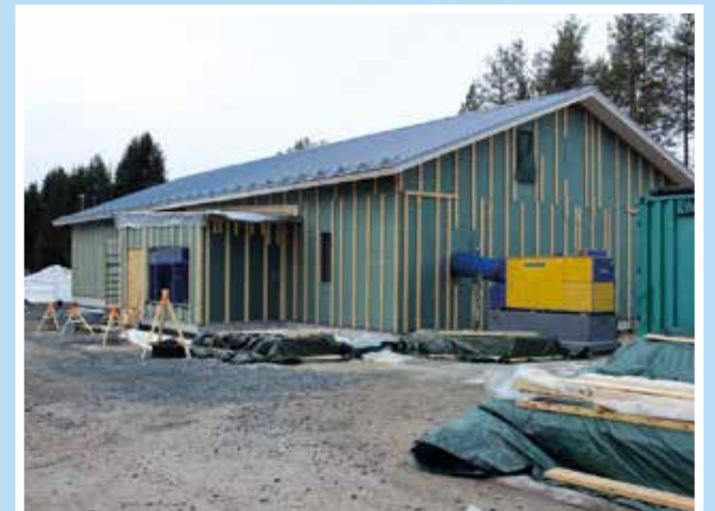
Ojakylän koulun uudisrakennus valmistuu elokuussa 2019. Samalla poistuu käytöstä koulun vanhin osa.
