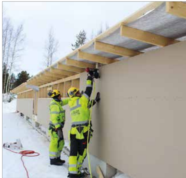
Salera Oy:n Mika Ronkainen ja Ari Järvenpää Kiinteistö Oy Iin Varastot työmaalla.
