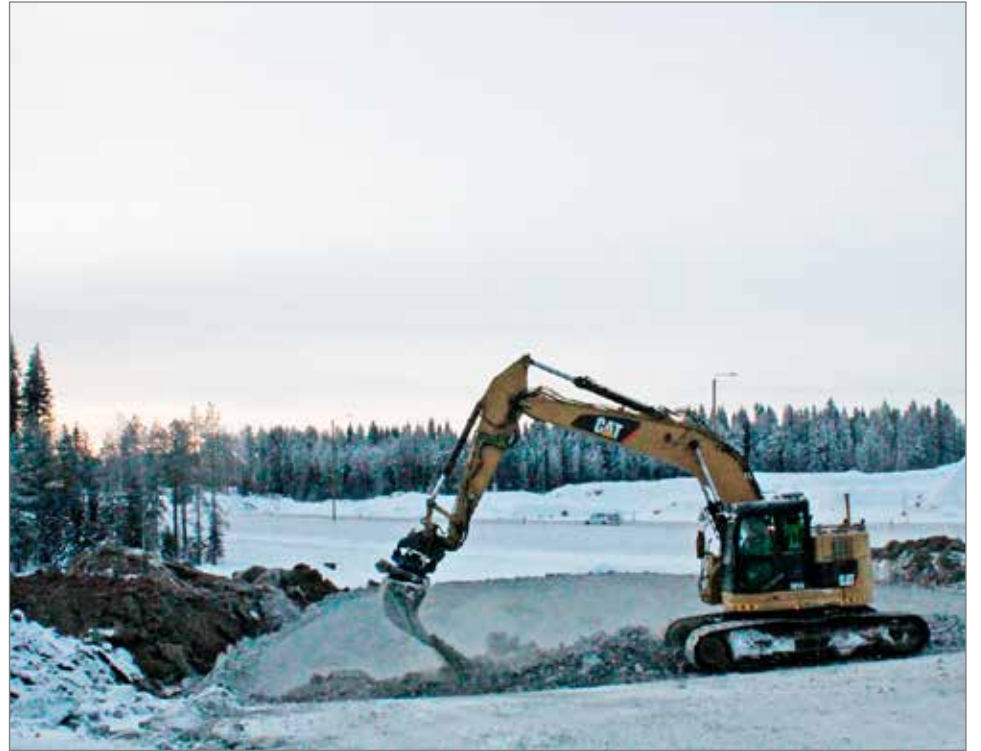
Ranuantien eritasoliittymän rakentaminen käynnistyi loppuvuodesta 2021 ja valmistuu syksyyn 2023 mennessä.
