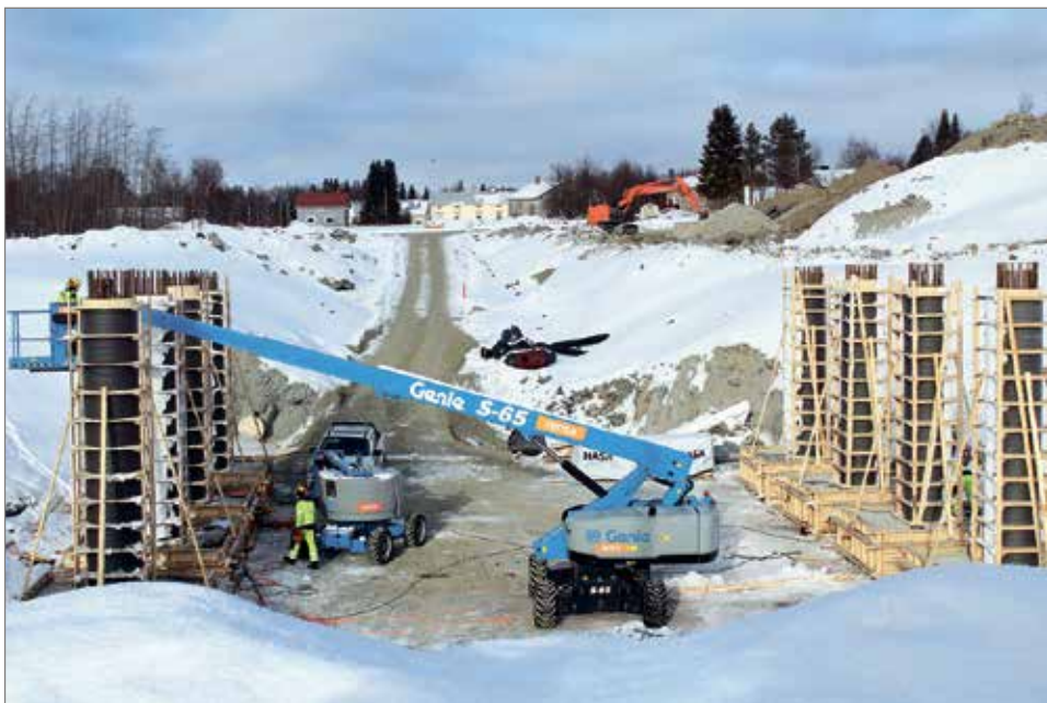
Maksniemen koulun kohdalle rakennetaan alikulkusiltaa helpottamaan koululle liikkumista.
