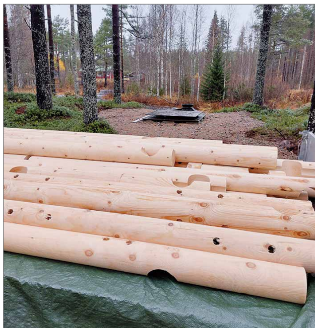
RoihuPuun työstämät puut rakennuspaikalle siirrettyinä.
