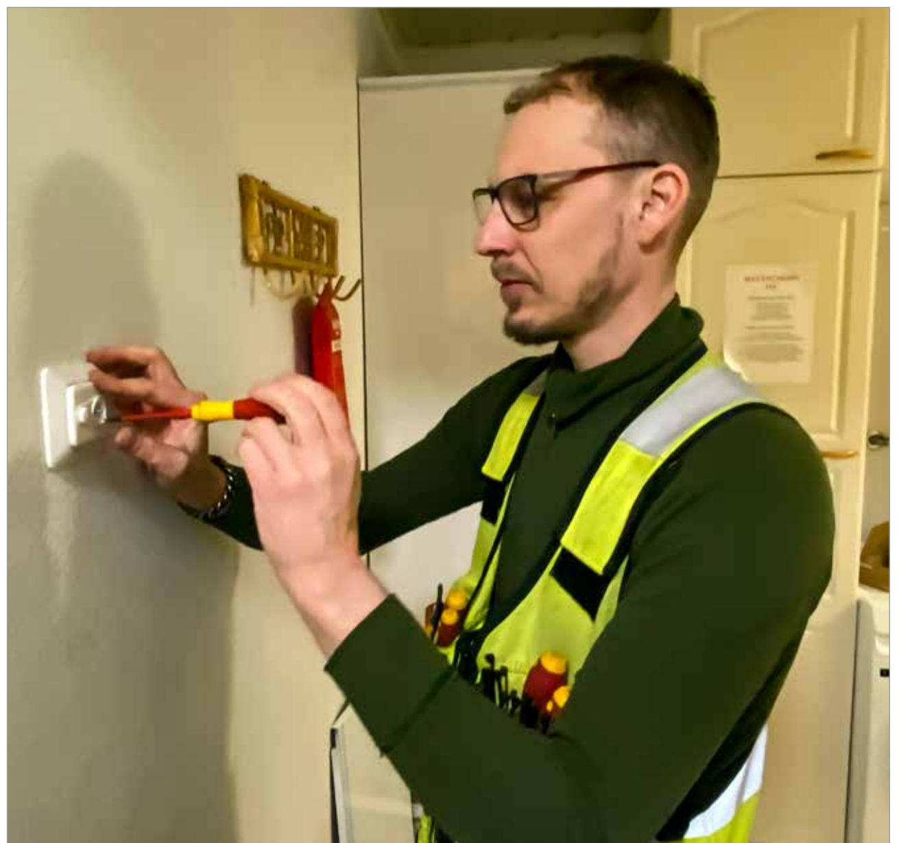
Marko Leminen asentaa termostaattia omakotitalon lattialämmityksen. Kuva Mauri Hietala.
