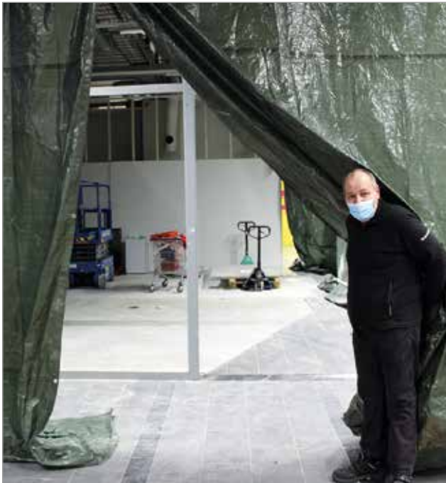
Myymläpäällikkö Reijo Hirvasniemi raottaa salaisuuden verhoa muutostöiden kohteena oleviin laajennustiloihin.
