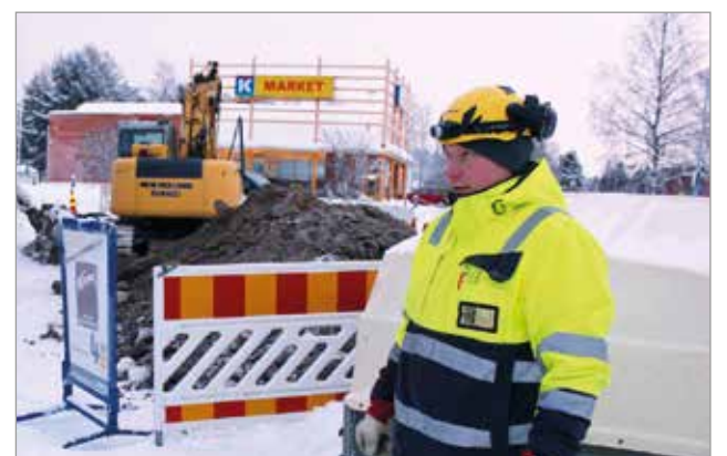
Iin Vesiliikelaitoksen asentaja Pasi Keltamäki korjaustyössä Jäppisen huoltamon nurkalla.
