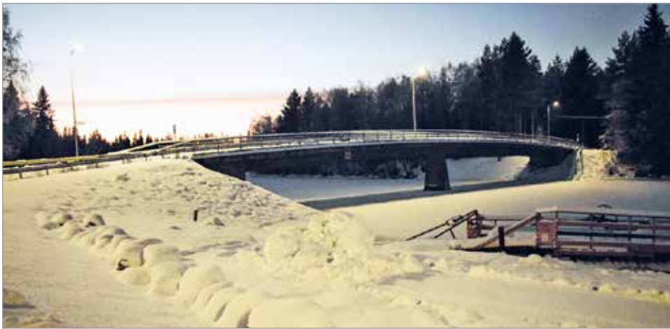
PT Pohjanteko osallistui Karhun saaren sillan rakentamiseen.
