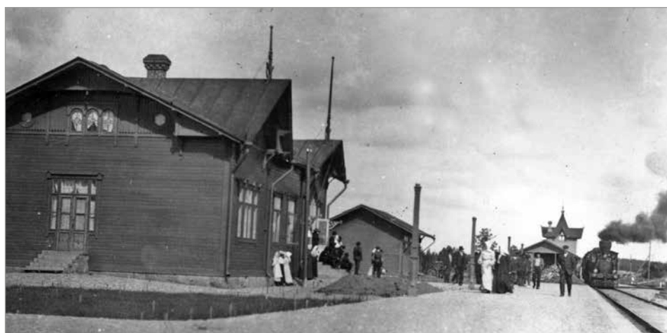
Olhavan asema 1900-luvun alussa, jolloin ei ollut halkojen tiputussiltaa. Vesisäiliön koristeellinen torni näkyy veturin vieressä ja sen edessä halkokatos
