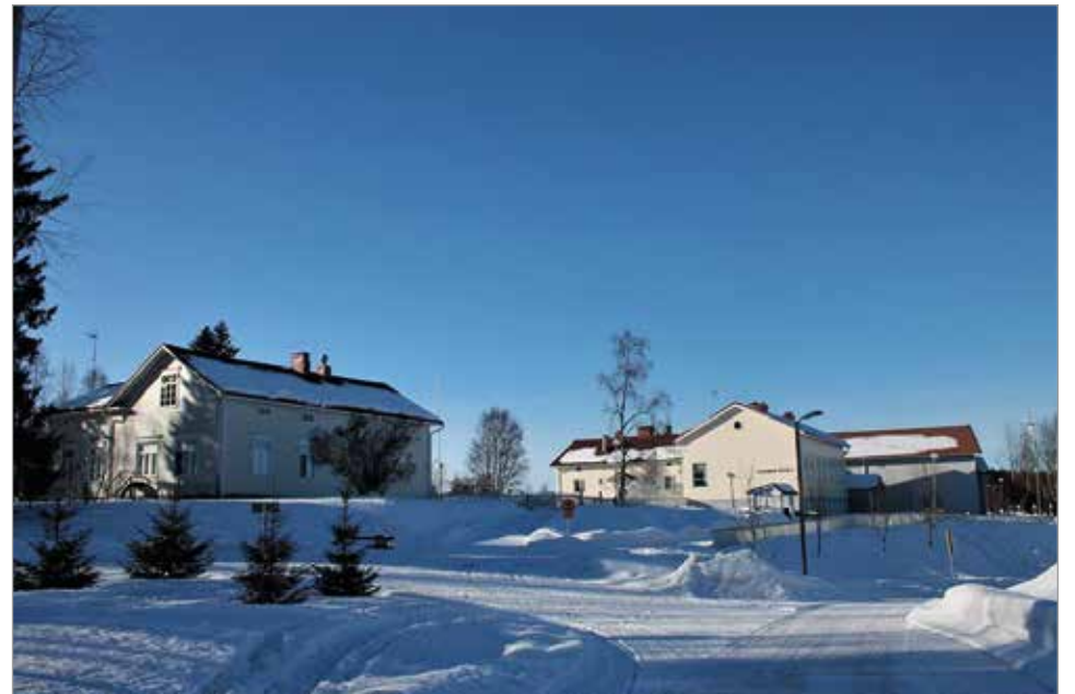
Olhavan ryhmäperhepäiväkotia Tenavatupa vasemmalla ja oikealla Olhavan koulu liikuntasaleineen. Molemmat rakennukset ovat terveitä, eikä korjaustarvetta ole. Sijainti on erinomainen 4-tien varrella, Oijärventien risteyskunnan tuntumassa.
