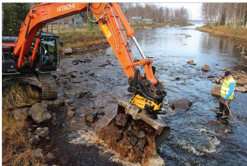
Sillan alapuolella pohjaa muotoiltiin konevoimin Heikki Tahkolan valvovan silmän alla.
