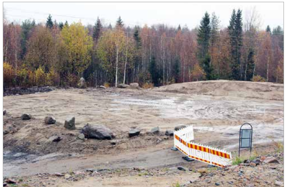
Uuden parkkialueen reunakivet tullaan maalaamaan ennen talven tuloa, jolloin alueen rajat ovat helpommin havaittavissa.
