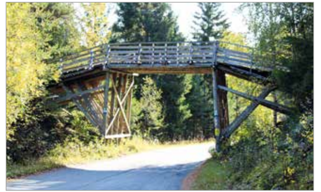
Illinsaaren kuntoreittien vanhempi silta on rakennettu 1980-luvun alussa. Sillan kansi on irrotettu useita kertoja paikaltaan talopakettirekkojen tieltä.
