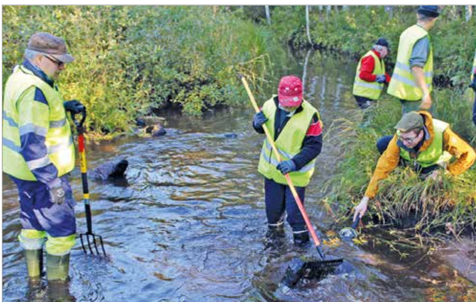
Kutualueen kunnostuksessa puhdistettiin kutosoraa ja muutettiin veden virtausta kivien siirrolla.
