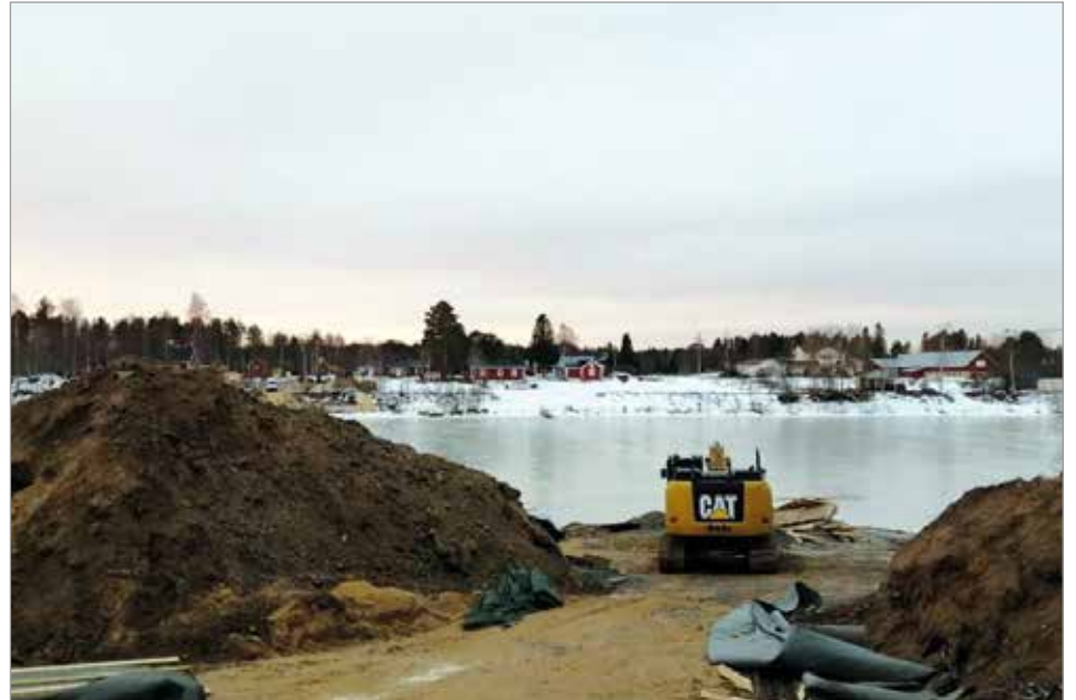
Näkymä samasta ikkunasta siltatyömaalle 9.1.2020
