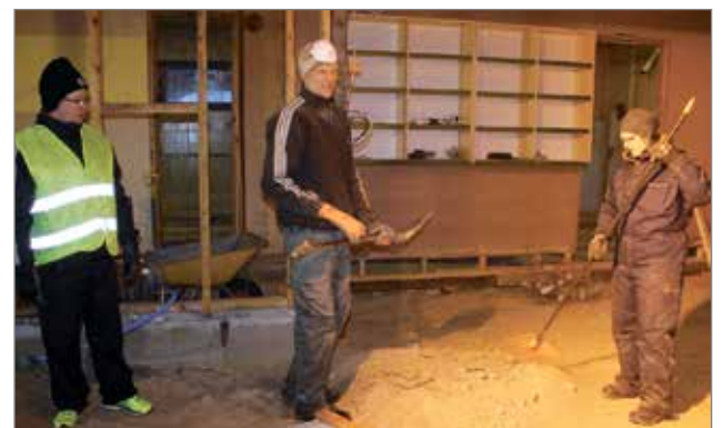
Veera Kuha ja lapsista kuopus Jarkko Kuha lapioimassa ylimääräistä hiekkaa lattia pohjalta ennen tyrosieristeiden laittamista ja betonivalua. Naapuri Pentti Piri poikkesi tervehtimään iltalenkinä yhteydessä.
