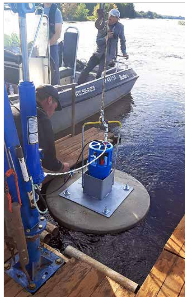
Karkottimet sijoitettiin lijoen pohjaan Simakkasaaren ylänokan kahdalle.
