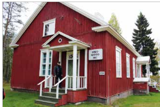
Siku-Moto MC on kunnostanut tiloja vuosia ja tähän päätyyn vaihdettiin kolme alinta runkohirttä, puheenjohtaja Jussi Oinas toteaa.
