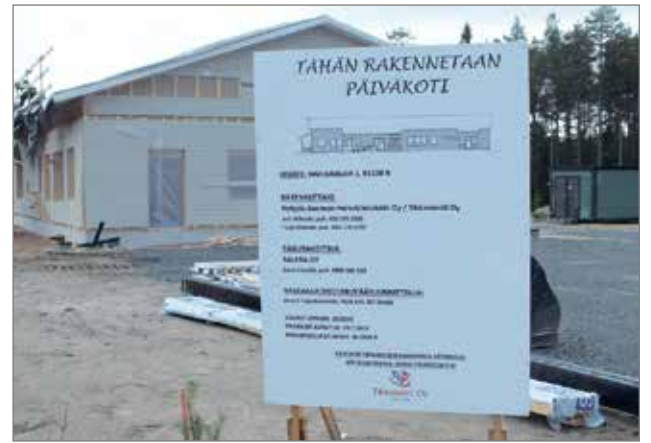
Päiväkoti Harjuntähti sijaitsee keskeisellä paikalla Harjungkujalla.
