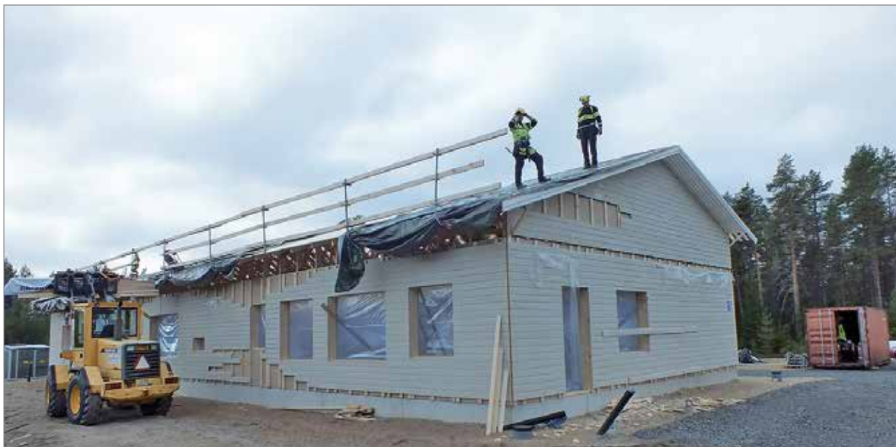
Mika Ronkainen ja Ari Järvenpää Salera Oy:stä työn touhussa Harjuntähden katolla.
