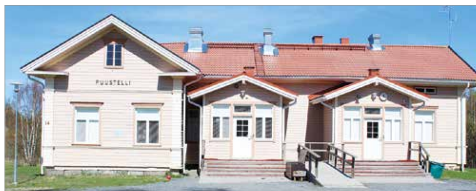
Alarannan uuden koulun valmistuttua Puustelliin sijoittuvat teknisen käsityön luokkatila, terveydenhoitajan tilat ja monitoimitila.
