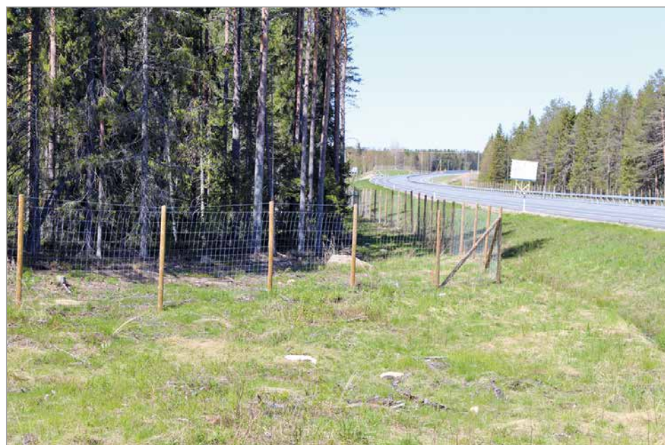
Oikein käytettynä suurriista-aita lisää huomattavasti liikenneturvallisuutta.
