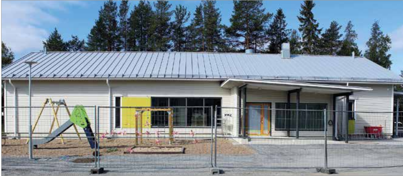
Ojakylän koulun uudisrakennus Härmä luovutetaan lin kunnalle 30.8.
