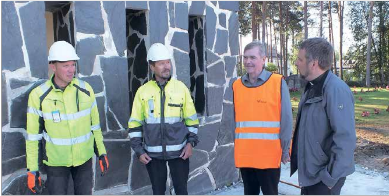
Vastaava työnjohtaja Kimmo Laitila Observo Oy, työmaan valvoja Markku Vitikka, Iin seurakunnan vt. talouspäällikkö Simo Paakkola, sekä Iin kirkkoherra Tapani Ruotsalainen toteavat kunnostusurakan alkaneen ripeästi.
