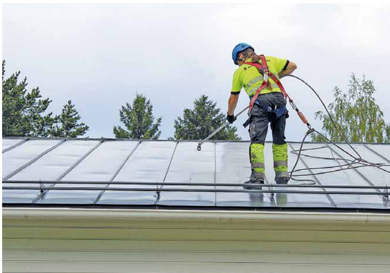
Mika Moisejeff peltikaton pinnoitus- eli maalaustöissä. Katto on ensin pesty liasta, sammaleesta ja jäkälästä. Mahdolliset ruosteet on poistettu ja reiät paikkattu, jos sellaisia on löytynyt.
