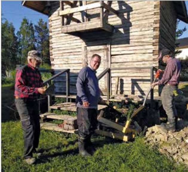
Kauko Vakkala, Pentti Ervasti ja Raimo Suomela aitan paalupe- rustusten viimeistelytyössä.
