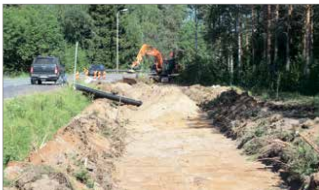
Hankkeen pääurakoitsijana toimii Maanrakennus J.Päkkilä Oy. Maansiirrot on aloitettu ja elokuussa kevyenliikenteenväylän on määrä olla valmis.
