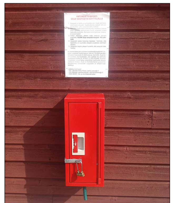
Vatunkiin on saatu ympärivuotinen vesiposti.
