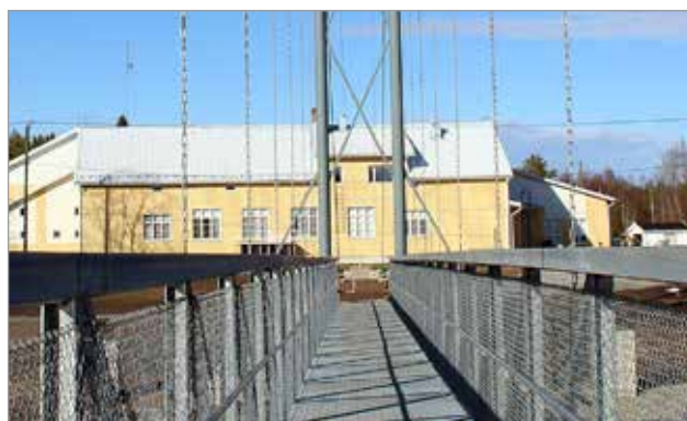
Siltakahvila on avautunut riippusillan koulun puoleisessa rannassa. Kuvassa pieni valkoinen rakennus oikealla.
