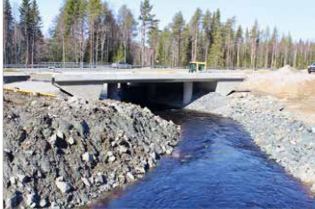
Siltatyö Muhojen kohdalla etenee suunnitelmien mukaan.
