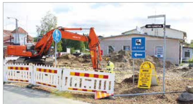
Runkovesiputken korjaus keskellä Iin keskustaa aiheutti muutaman päivän katkoksen liikkumiseen Kirkkotieltä Haminantielle.
