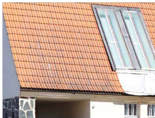
Iin kirkon kunnostustyöt jatkuvat ja käynnissä ovat muun muassa kattoikkunoiden alapuolisten osien korjaustyöt.
