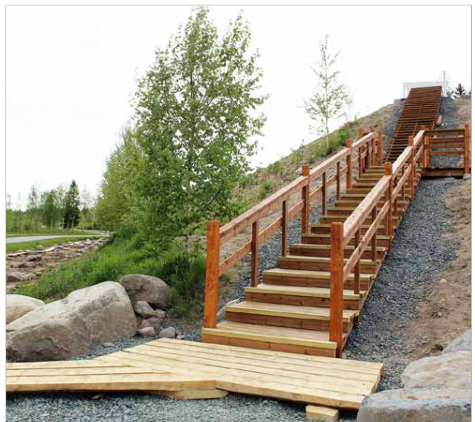
Liesharjuntien ja Sahatien risteykseen on valmistumassa uusi liikunta- ja virkistytymispaikka.
