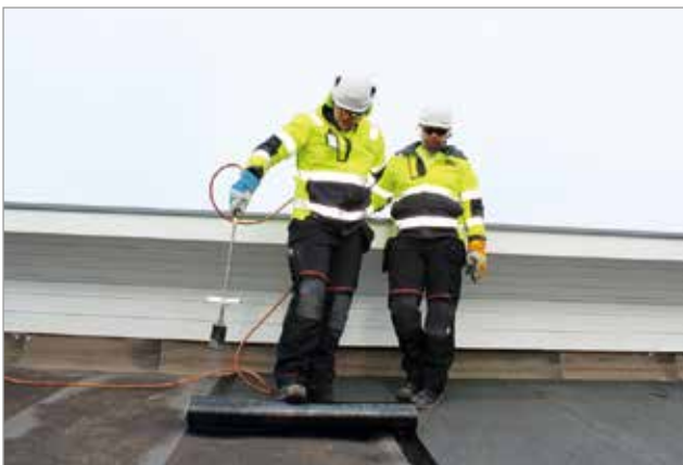
Katto- ja rakennuspalvelu BH Group on lähinnä huopakattoihin keskittyvä yritys. Juho Backman levittää kattohuopaa Jarno Huttun valvoessa työn sujumista.
