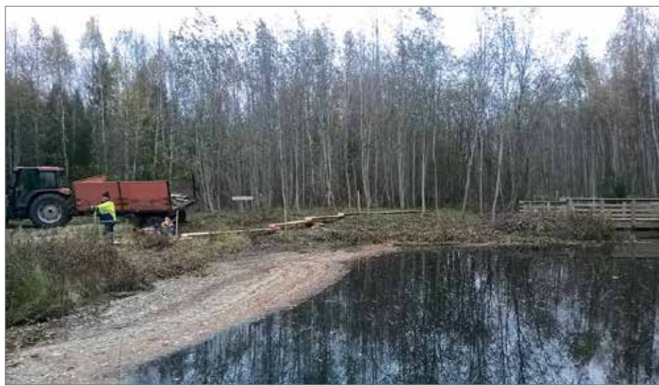
Ja syksyllä 2018 rakennettiin jatkopitkokset luontopolkualueelle.
