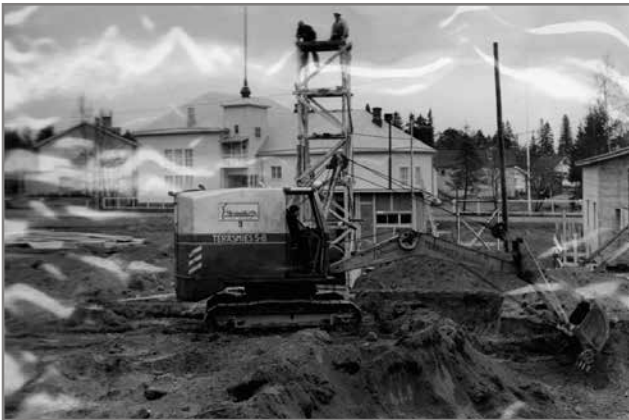
Iin Osuuskauppa keskuspaikka rakennettiin Laksonkatun varteen vuosina 1959-1960
