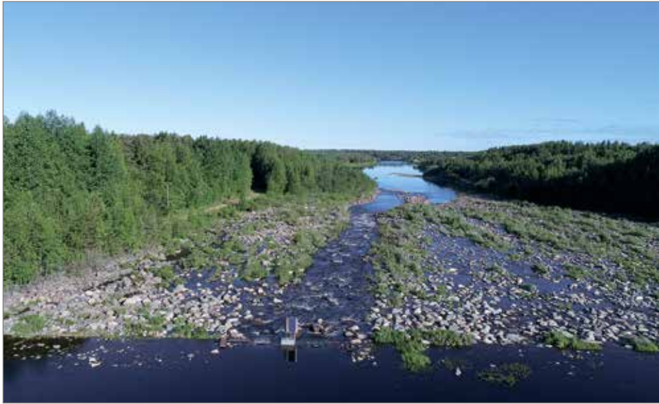
Uiskarin kalatie ja Iijoen vanha luonnonuoma mahdollistavat kalan nousun ja luontaisen lisääntyminen. Kuva Seppo Paakkola Drone kuvaus
