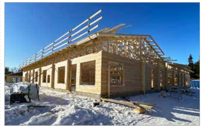
Helmikuussa uuden päiväkodin rakennustyömaa nousi Kauppapien varteen. Kuva Mauri Hietala.
