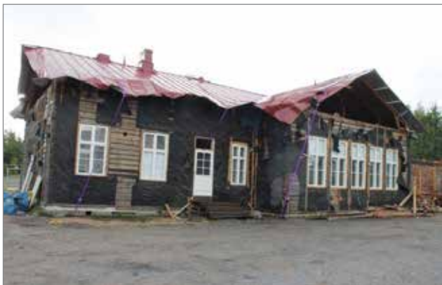
Pohjois-lin koulun vanhaa liikuntasalirakennusta puretaan. Myrskytuuli melkein irroitti koulun peltikaton, joten palokunta satoi sen kiinni.
