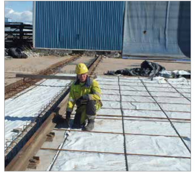
Tiiron Raudoituspalvelu Oy raudoittaa Iin Konepajan pihalle rakentuvaa 95-metristä piharataa.
