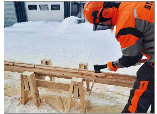
Jani Ahonen on oppinut, että varauksen tekemisessä on monta eri työvaihetta ennen kuin hirsi istuu hyvin seuraavan hirren päälle.
