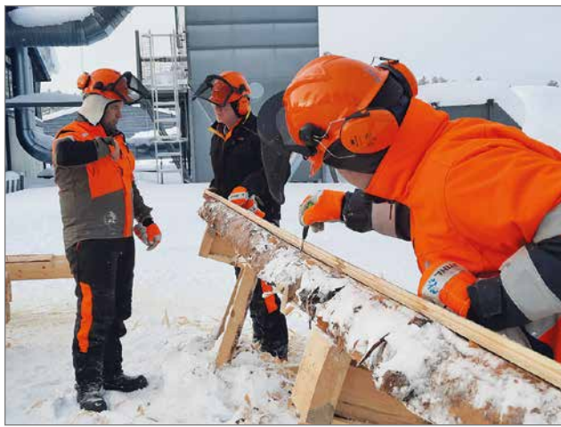
Vesa Kokko ja Mikko Määttä löysivät mieleisensä kurssin. Opettaja Marko Kehusmaa piirtää mallia, minkä verran hirren selästä kärsii vielä ottaa pois.
